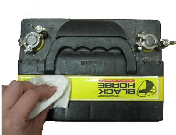
**Рисунок 5.** Очистка поверхности для наклеивания.
